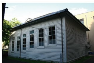
魯迅階段教室（1904 年建築）
